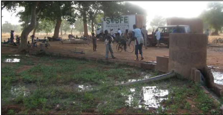
Photo 1 : Système d'irrigation du maraîchage et site de vente du haricot vert en arrière plan.
